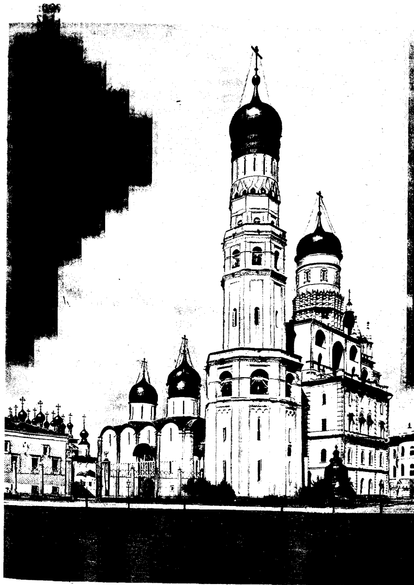
Бон Фрязин. Колокольня Ивана Великого. 1505—1508. Надстр. в 1600 г.
